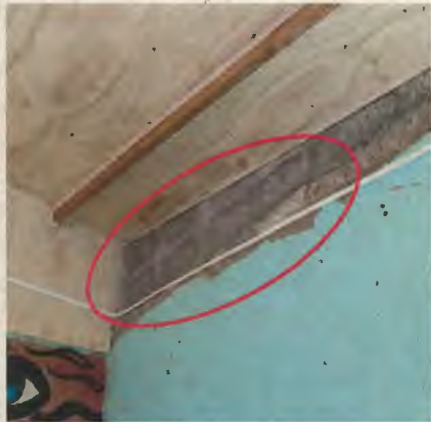
Foto 3: Muro de Albañilería de Bloques de Hormigón – Vista Interior.
