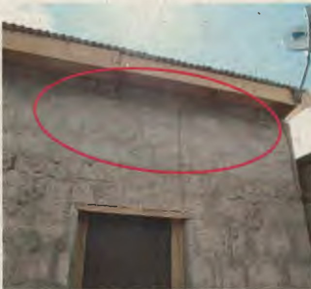
Foto 2: Muro de Albañilería de Bloques de Hormigón – Vista Exterior.
